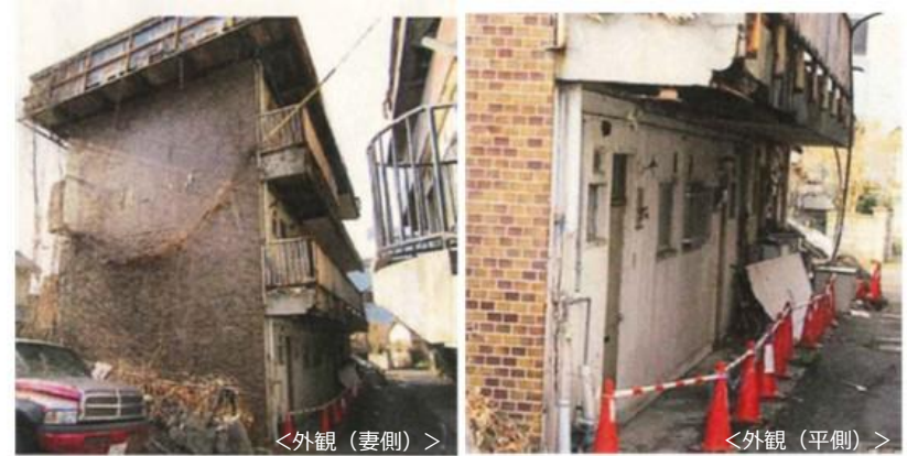
<行政が代執行により除却した事例>
